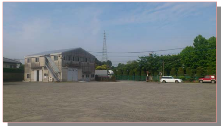
駐車場と事務棟
